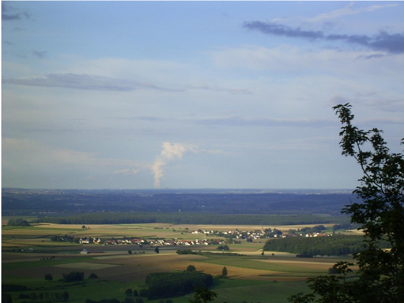
Deutschlands größtes und gefährlichstes AKW aus 74 km vom Bussen gesehen
