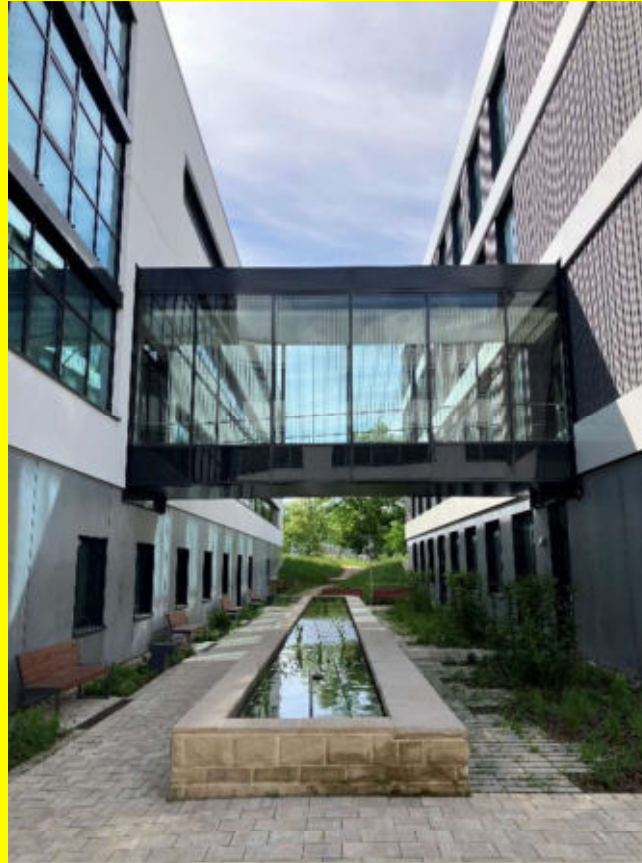
Neubau LUBW Karlsruhe
